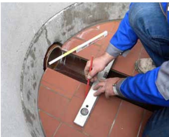
Anzeichnen der Aussparung für die Absperrreinheit auf der Auslaufseite des Schachtes.
