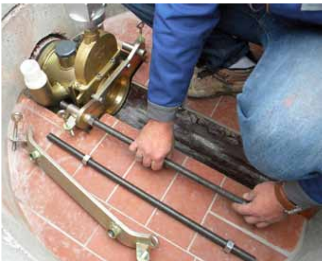
Die Absperrreinheit und der Einspannrahmen können jetzt montiert werden.
