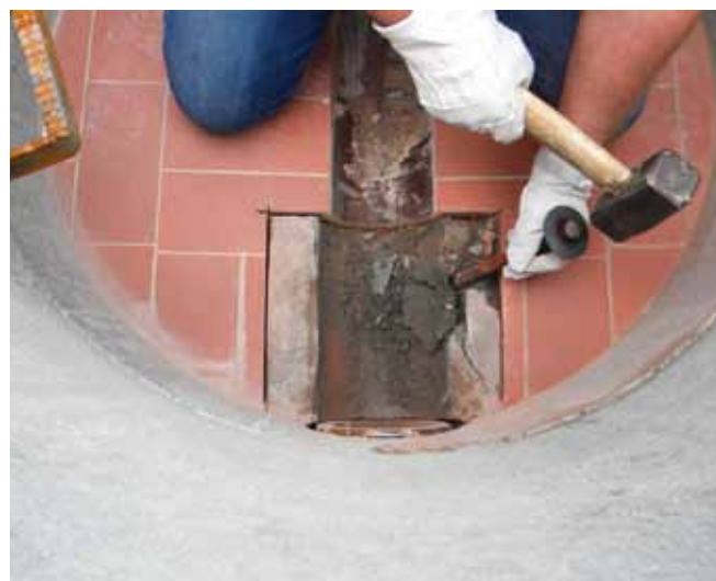
Angezeichnete Fläche anschneiden und Estrich bis zum Schachtboden entfernen.
