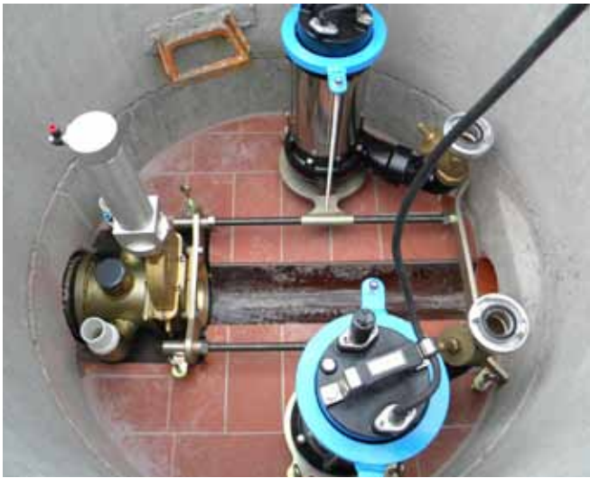
Nach der Installation der Fäkalienpumpen werden diese ...
